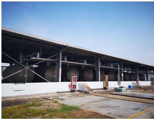
北厂区储罐区
