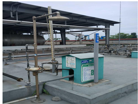
北厂区储罐区事故应急池
