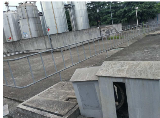
南厂区储罐区事故应急池
