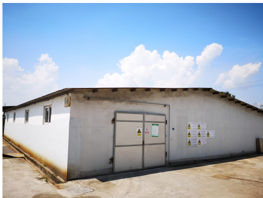
厂区危废暂存库
