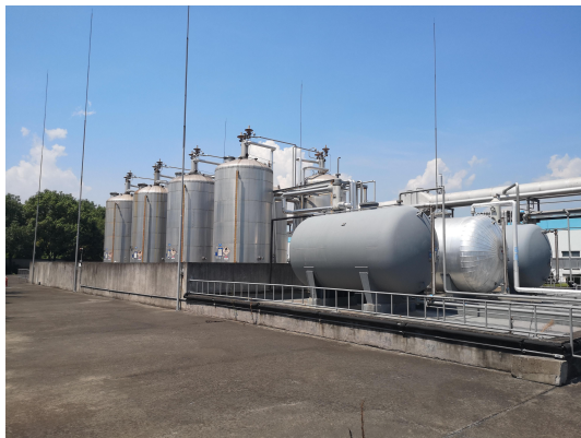
南厂区储罐区
